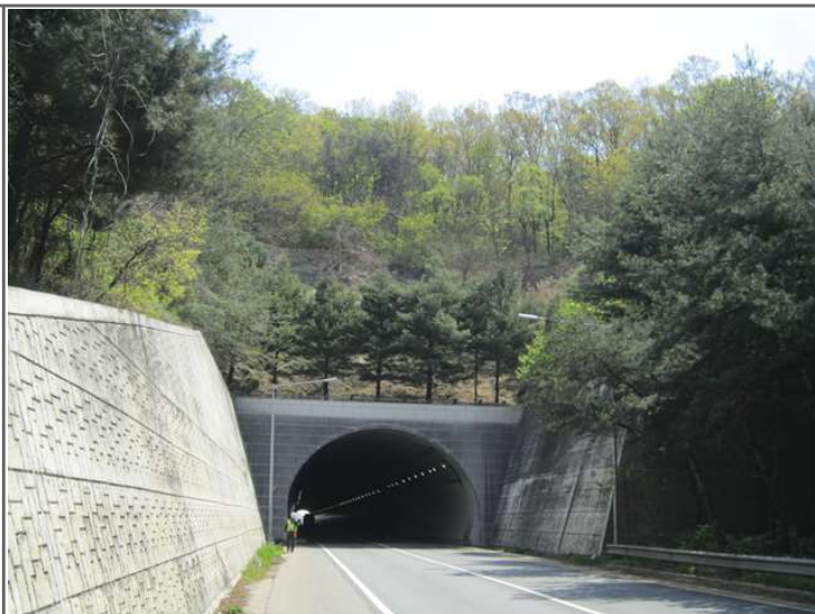
갭문 및 옹벽 전경
